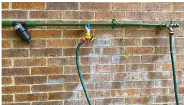
Figura 8. Sistema de distribución de agua lluvia con presión por gravedad en el ecobarrio la Esmeralda, Huerta JAC Colibrí, para sistema de riego.
