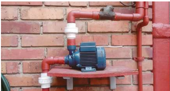
Figura 14. Bomba eléctrica instalada en inmueble residencial en el ecobarrio la Esmeralda.
