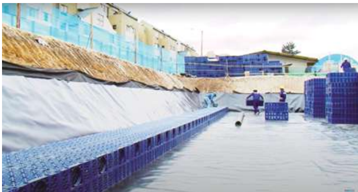
Figura 18. Sistema Aquacell Pavco Wavin en el Centro Comercial la Colina, Bogotá, 2016.
