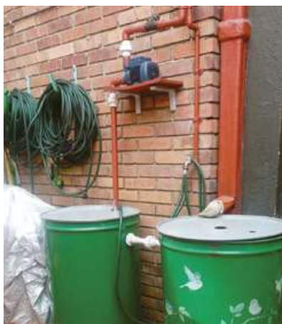
Figura 12. Sistema de captación, almacenamiento y riego con agua lluvia en inmueble residencial, en el ecobarrio la Esmeralda.
